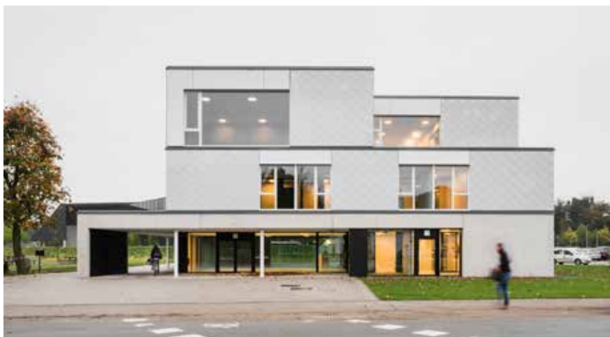
Foto 6. VIVES nam eind 2017 in Brugge een nieuwe infrastructuur voor zijn dienst studentenvoorzieningen (STUVO) in gebruik, een investering van 2,5 miljoen.
