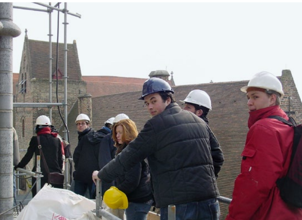
De cursisten komen letterlijk op de steiger, om zich te kunnen inleven in de concrete realiteit van een restauratieproject.
