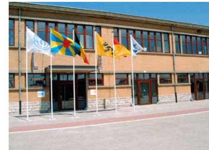
Provinciaal Ankerpunt Kust, in de voormalige pakhuizen van de Oostendse vismijn
