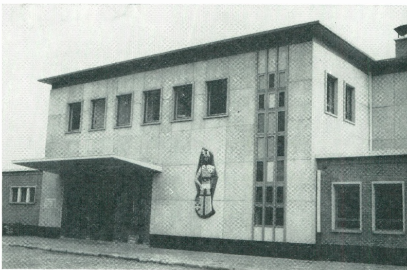
Nieuw Stationsgebouw te Ieper (Foto G. Bossaert)
