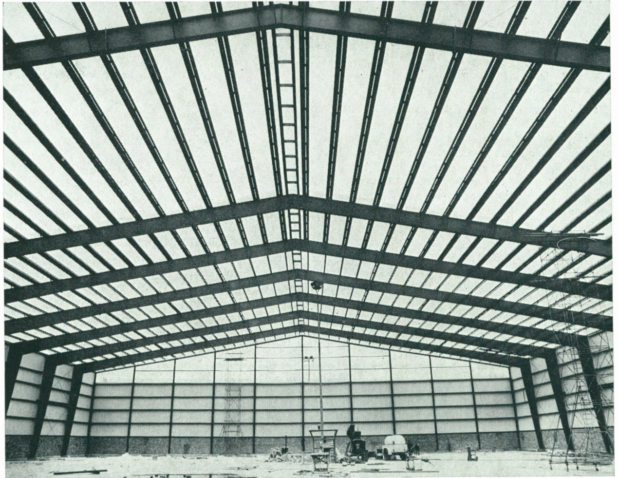
Opslagloods in opbouw van 5.000 m 2 met 62 m vrije overspanning in de Haven van Antwerpen.
