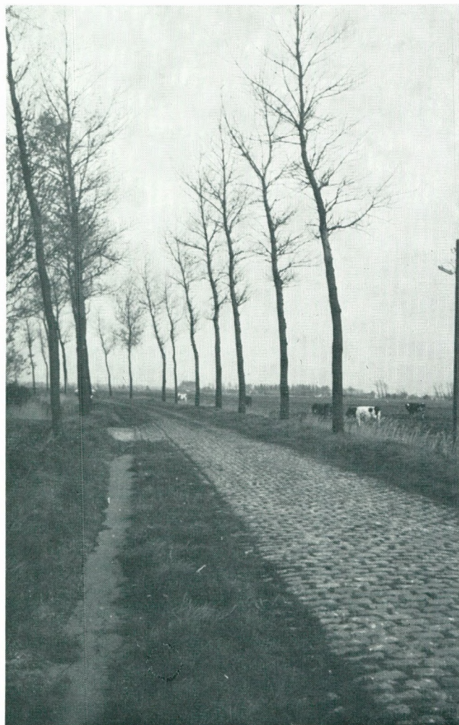
Provincieweg te Zande 3 m breed + 2 x 1 m. Het profiel 'Cloet' op een ondertussen reeds verlaten wegvak (1977)
