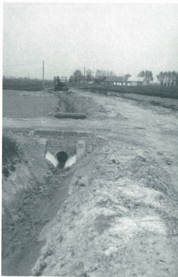
Nieuwe weg in aanleg.
