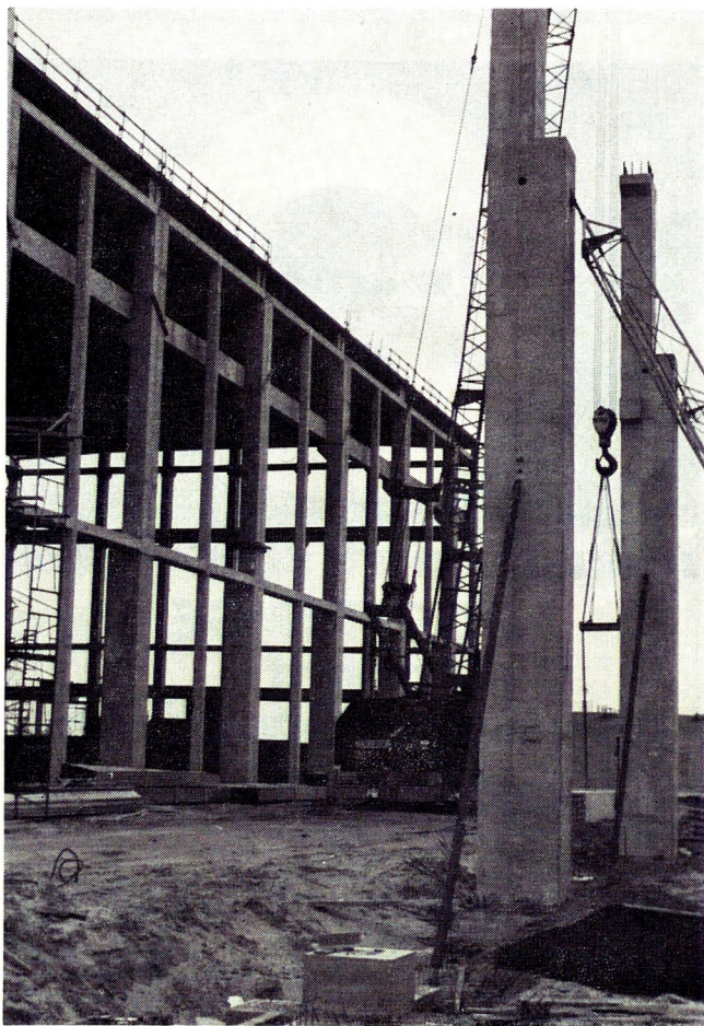
Nieuwe montagehal in opbouw
