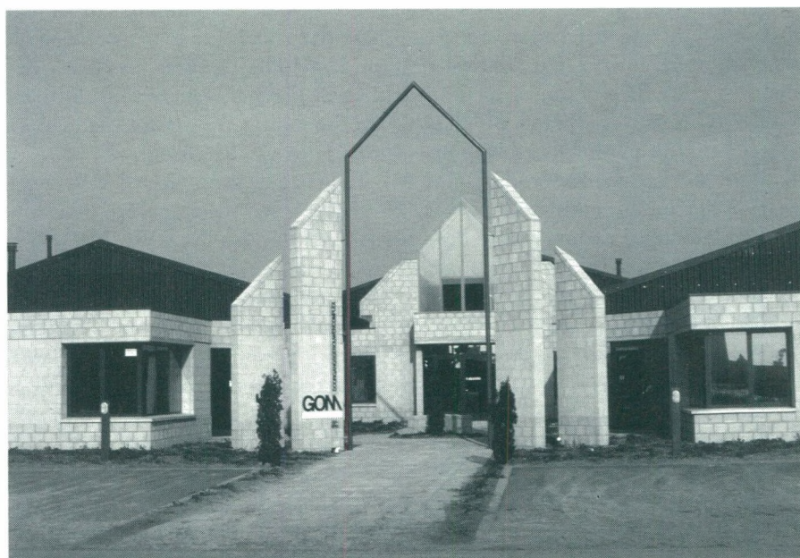
Ontvangststructuur voor bedrijven: doorgangsgebouw Ieper.
