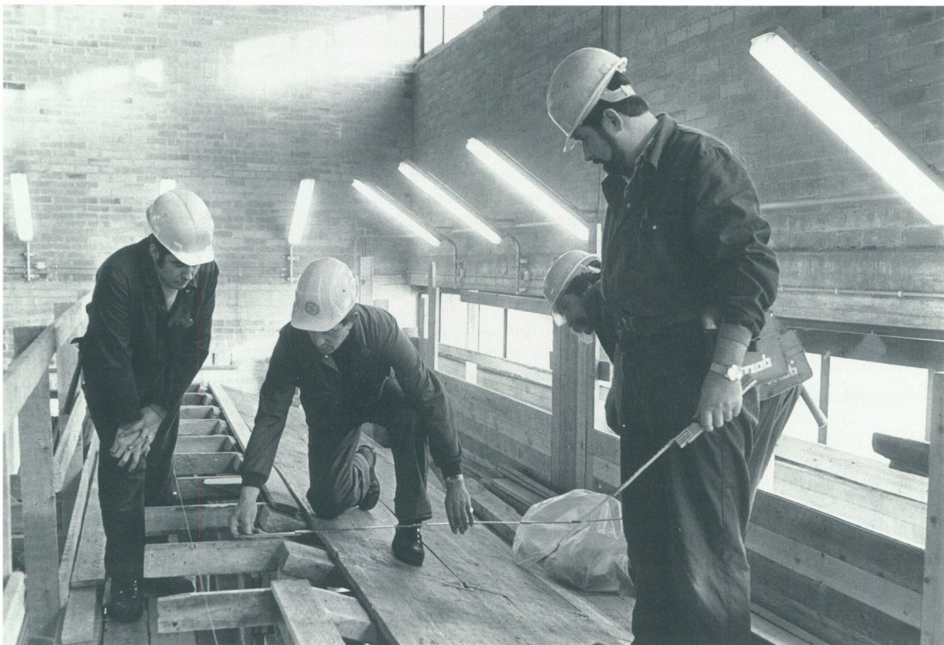
RVA opleidingscentrum Wevelgem.
