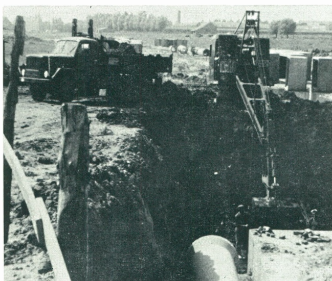
Grondwerken industrieterrein te Ieper. Overwelving van de Bellewaerdebeek.
