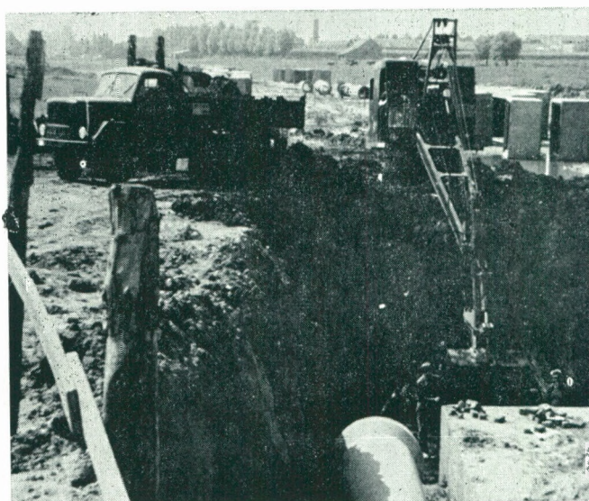
Grondwerken industrieterrein te Ieper. Overwelling van de Bellewaerdebeek.
