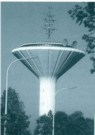
Waterdichtende en carbonatiewerende coating uitgevoerd door Pentagon Plastics
