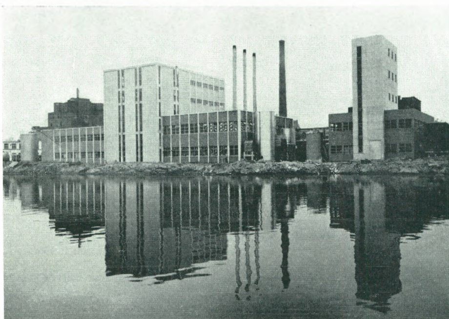
Nieuw fabrieksgebouw Kon. Nederlandse Gist- en Spiritusfabriek, Brugge.
