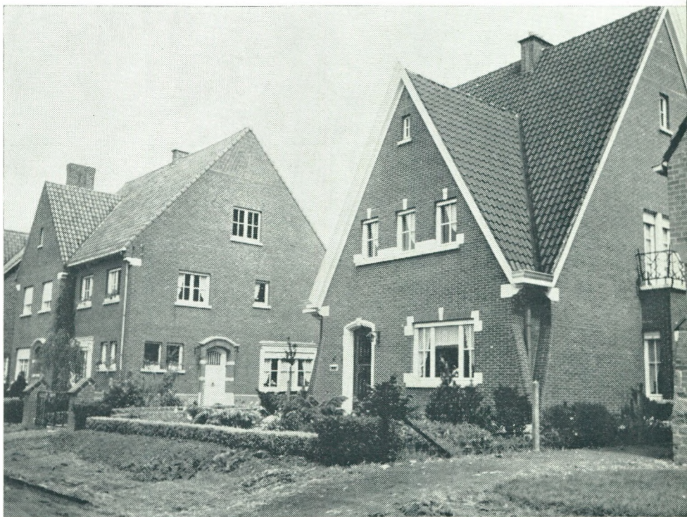
HUISVESTING Sociale woningbouw te Kortrijk.
