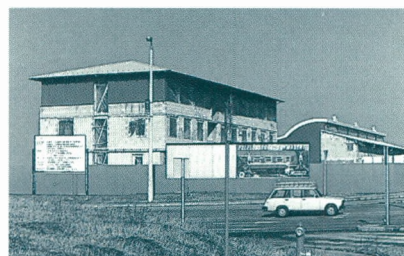
Het bedrijvencentrum Somogy-Flandria in opbouw
