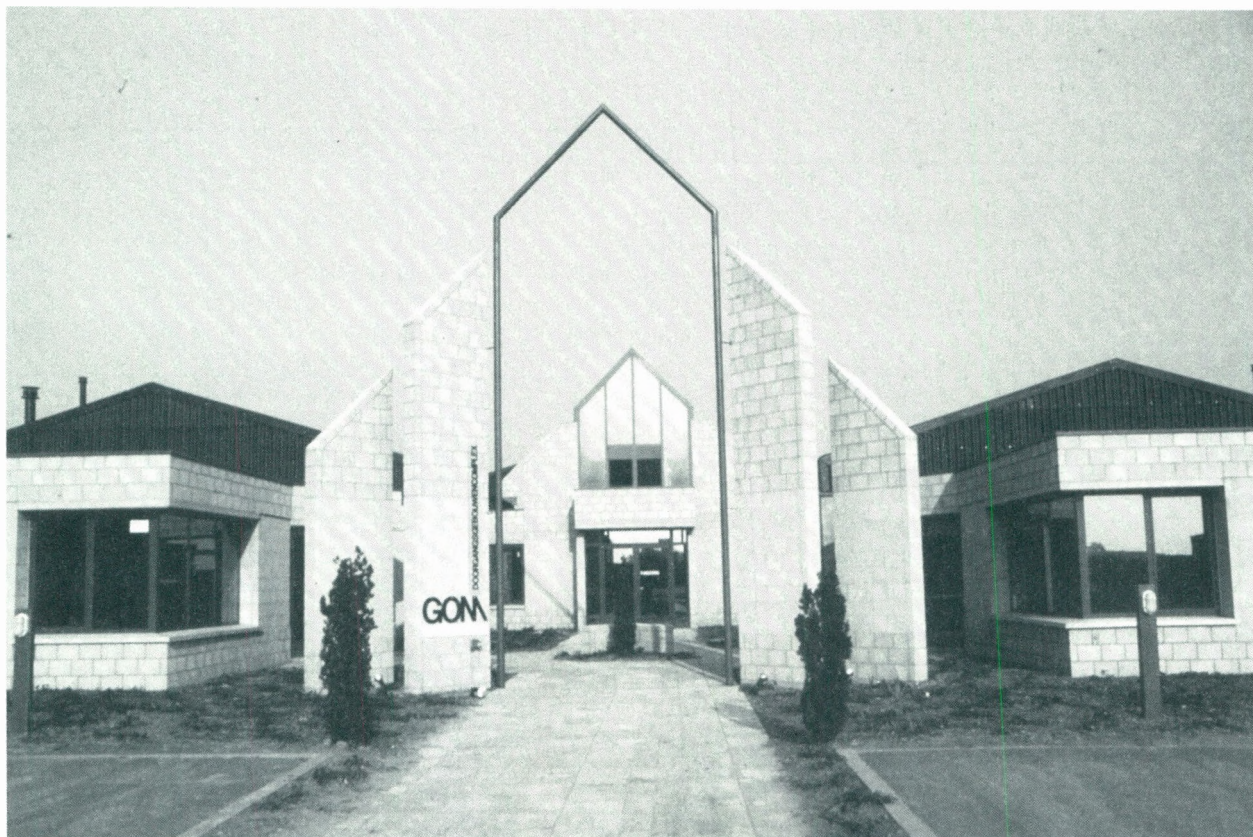
Doorgangsgebouw te Ieper.
