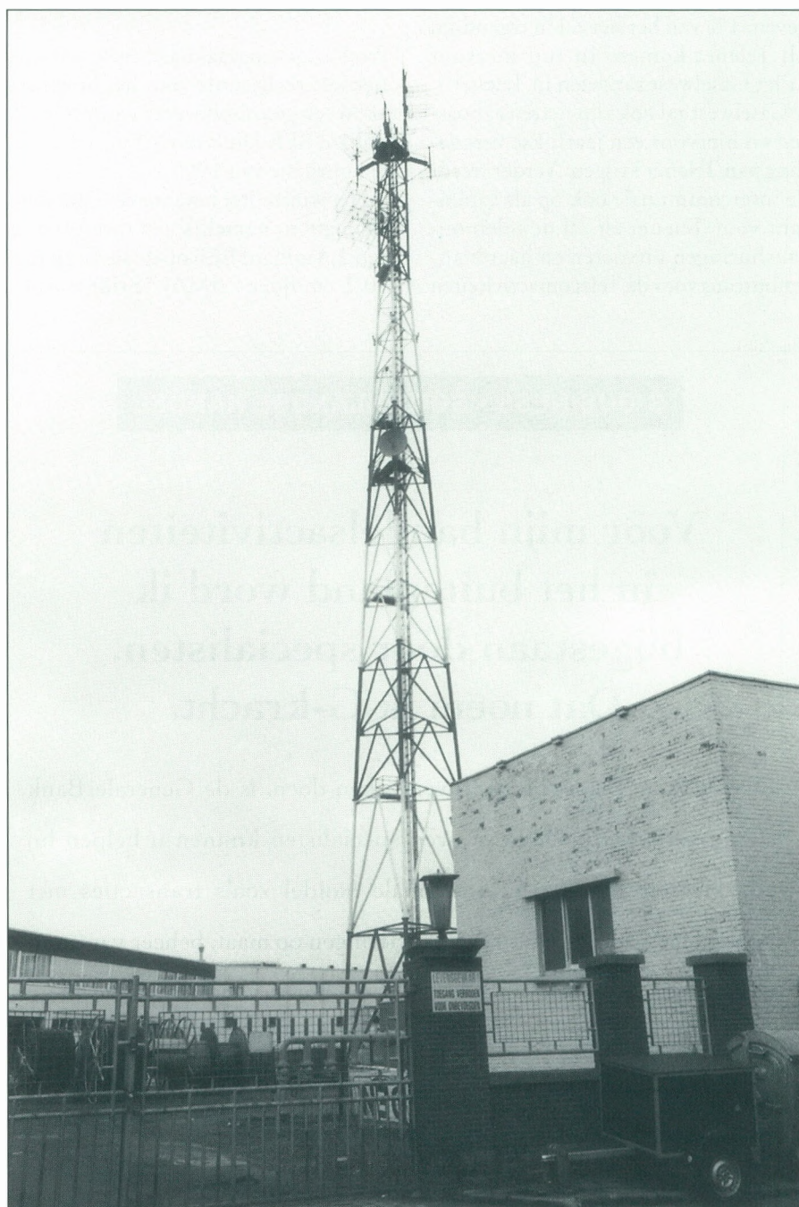
Antennemast te Roeselare.
