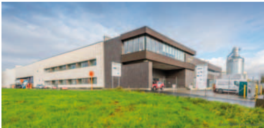
Recticel investeerde in performante nieuwe productie-infrastructuur in Wevelgem (foto Recticel)
