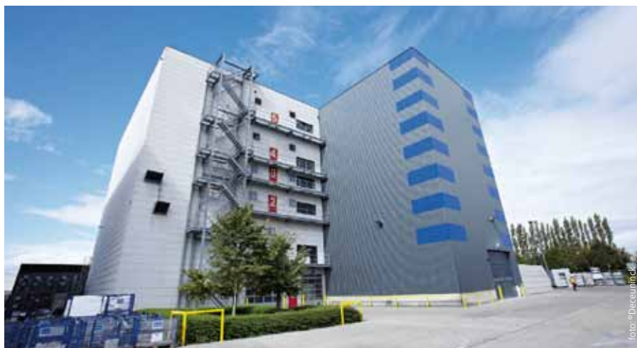
De nieuwe pvc-recyclingplant in Diksmuide
