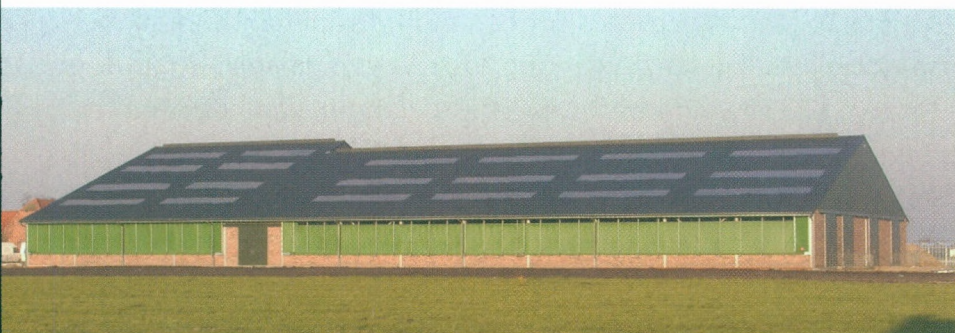
■ Het is aanbevolen de lichtdoorlatende platen in een strook aan te brengen. Het onderbreken ervan heeft bovendien een verkleinend effect
