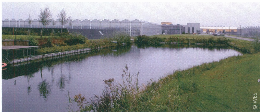
■ Goed voorbeeld van ecologische integratie van het spaarbekken in dit Nederlands glastuinbouwbedrijf.
