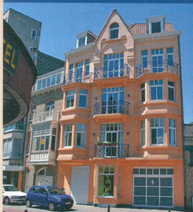
Volledig gerenoveerd pand in de Sloepenlaan
