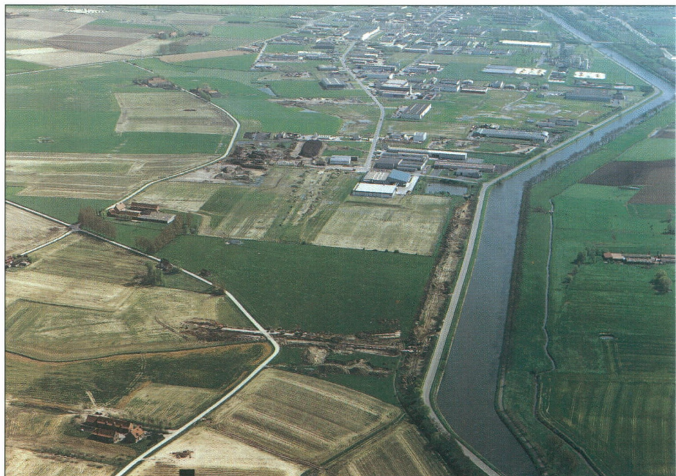
De systematische uitbouw van bedrijventerreinen is een wezenlijk element in de economische streekontwikkeling. Op de foto: uitbreiding leperleekanaal.
