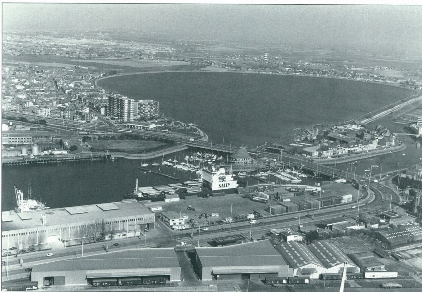
Haven van Oostende, diepwaterkaai en spuikom.
