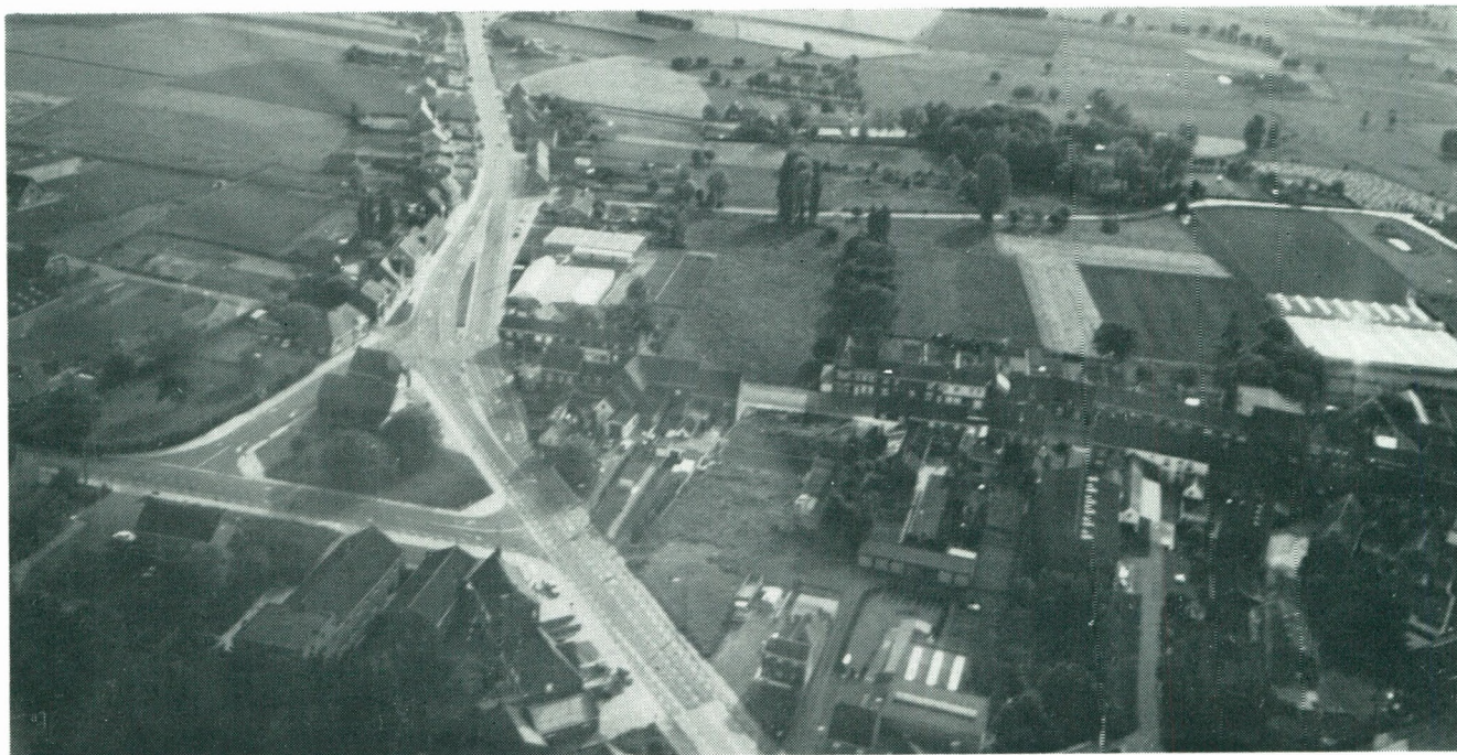
De verbinding van de twee provinciewegen te Westrozebeke (foto 1978)
