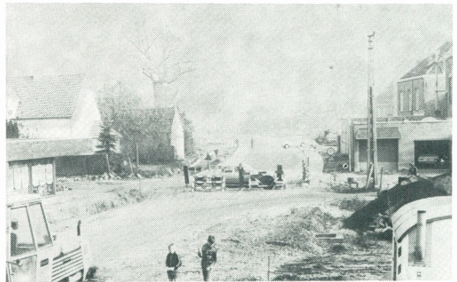
De werken in uitvoering in de doortocht te Loppem (1975)
