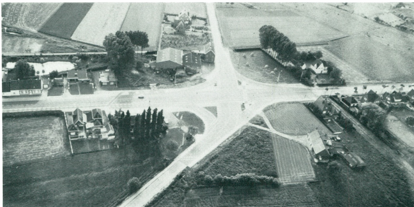
Het in 1977 gemoderniseerde verkeersknooppunt t.h.v. de Statiestraat te Gits (foto 1978)
