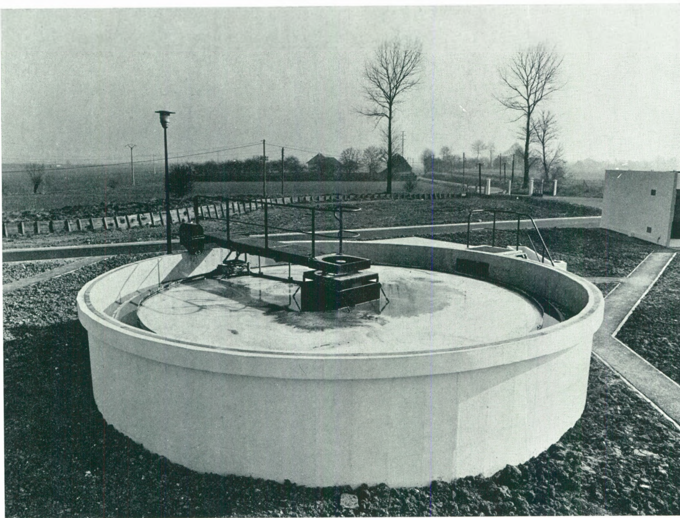
Waterzuiveringsstation met beperkte capaciteit.
